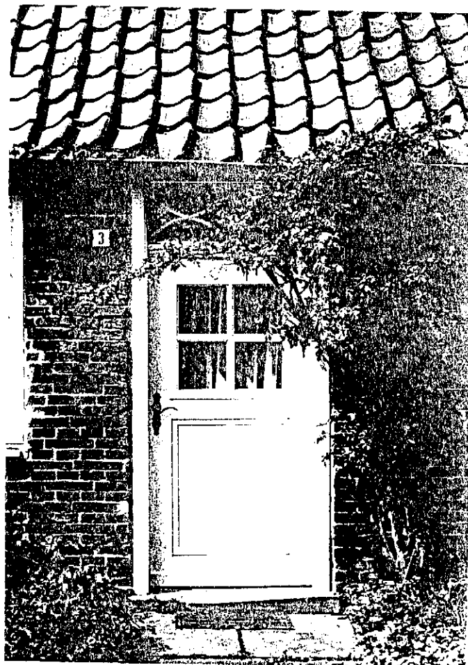
Noorderloog Nr. 3 Seiteneingang Maßstäbliche Erneuerung einer alten Tür mit Ober- licht und erhaltene Sand- steinschwelle
