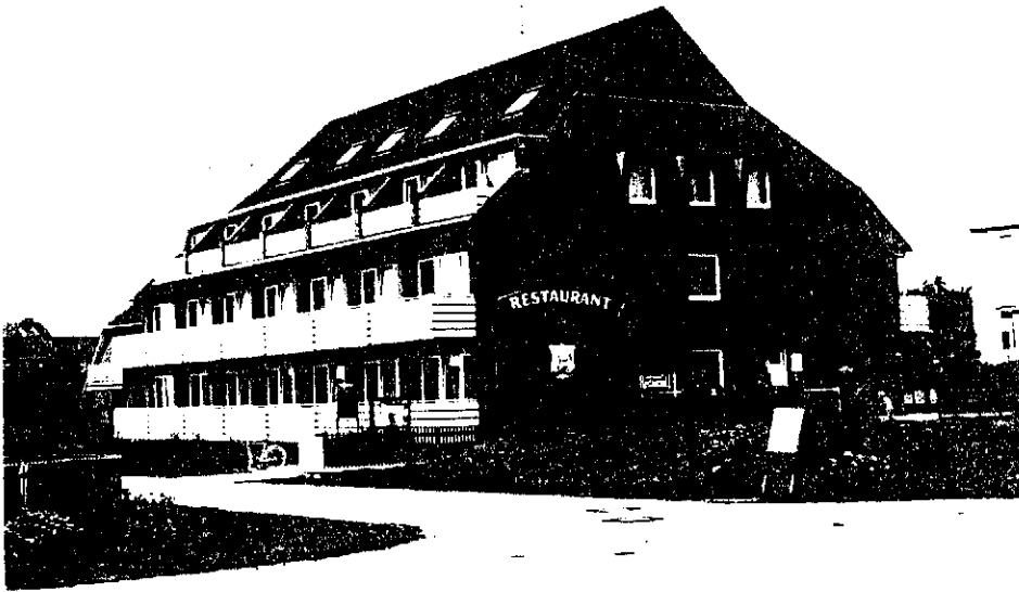
Pollerdiek Nr. 4 1980 Bei zulässiger Zweigeschossigkeit eher viergeschossige Nutzung. Das Dachgeschoß durch Dacheinschnitte und durchgängiger "Gaube" ein weiteres Vollgeschoß
