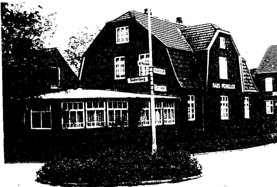
Süderloog Nr. 2 Um 1926 Krüppelwalm/Mansarddach trotz nutzbarer Zweige- schossigkeit niedrige Traufenhöhe Windfedern Veranda Hecke
